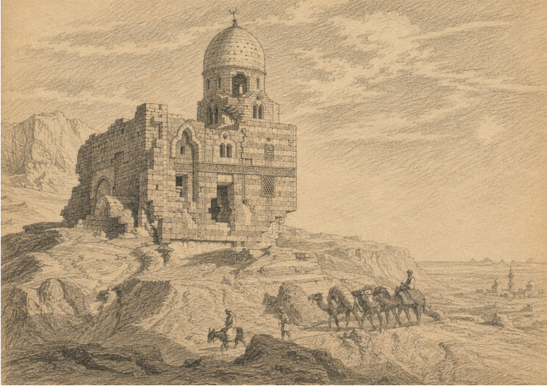
Baybars Türbesi, Kahire
